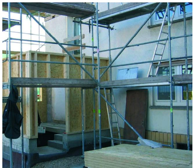
*In Holzrahmenbauweise erstellter Vorbau als Windschutz an massiv gebau-tes Wohnhaus. Im Zuge dieser kleinen Anbaumaßnahme wurde auch gleich die bestehende Fassade mit gedämmt.*
