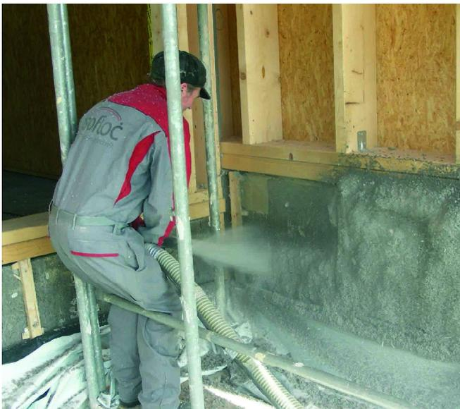
*Hier wird Zellulose als Dämmstoff eingeblasen. In der Innendämmung ebenso einsetzbar wie nachträglich als Außendämmung an der Fassade. Im Wärmeschutz ebenso überzeugend wie im Brandschutz überzeugt diese umweltfreundliche und schadstofffreie Material immer mehr Bauherren.*
